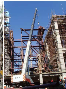
Котел-утилизатор производительностью 75 т/ч Группа компаний «ШэньХуа»
