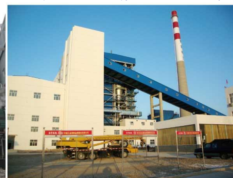
Хэбэйская энергетическая компания Котел производительностью 130 т/ч
