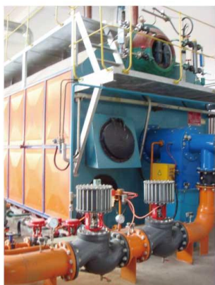
Мазутный котел производительностью 10т/ч (Аньшаньский институт тепловой энергии)
