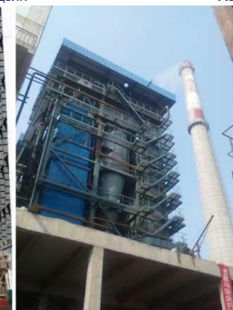
Котел (75 т/ч) ТЭС Тяньюань, Пров. Шаньдун
