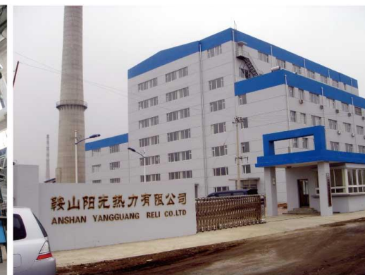
Котел мощностью 58 МВт Аньшаньская компания по производству солнечной энергии
