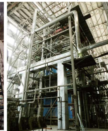
Газовый котел с высокой степенью защиты (130 т/ч) Гр. компаний Ганте (пров. Ляонин, г. Бенси)
