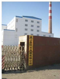
Котел мощностью 12 МВт ООО «Мишень» Уезд Хэйшань (пров. Ляонин)
