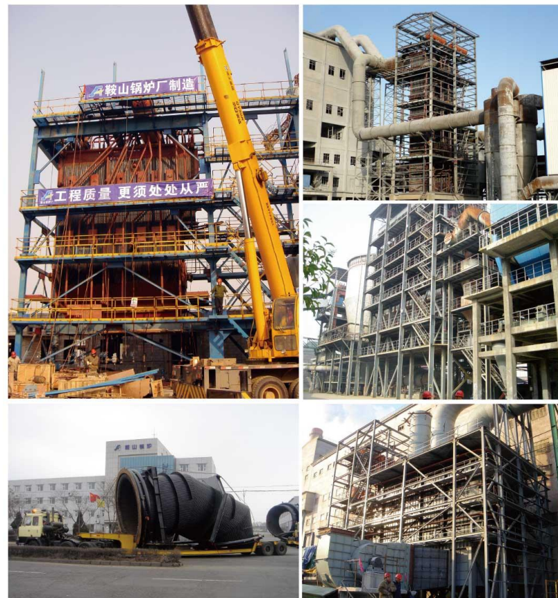
Котел-утилизатор для карбидной печи (10 т/ч) Предприятие химической промышленности «СиньМяо», пров. Ганьсу
